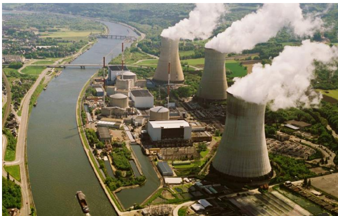
La centrale électrique thermique nucléaire de Tihange
